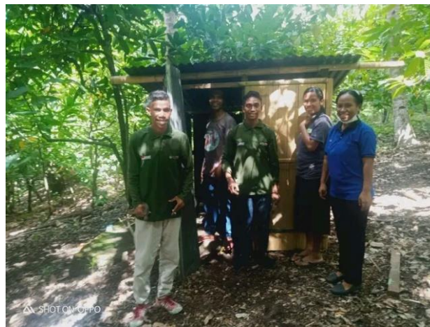
Gambar 1. Pembangunan Jamban masyarakat Bola
