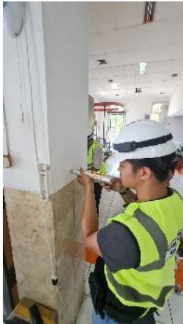
Gambar 4. Pengujian Struktur Kolom
