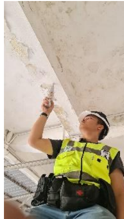
Gambar 5. Pengujian Struktur Balok
